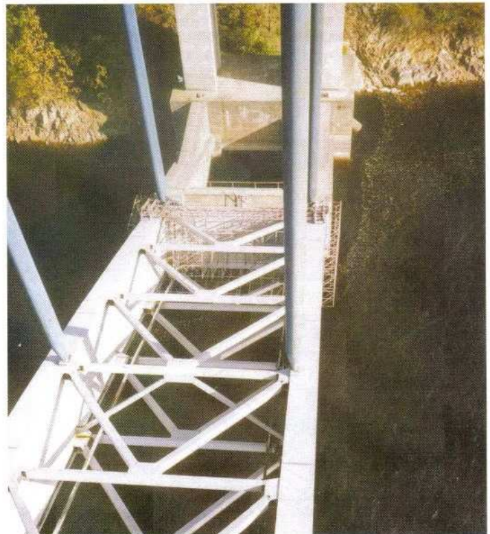
▲ Pohled na ztužení konstrukce mostu
